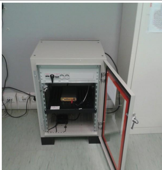
Armadio contenente il ricevitore ed il gruppo UPS
